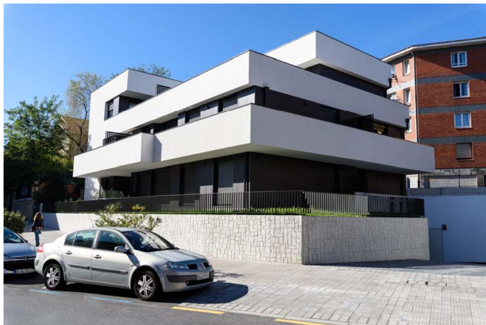
Residencial Andikoetxe– Getxo (Bizkaia) - Obra nueva edificación.
