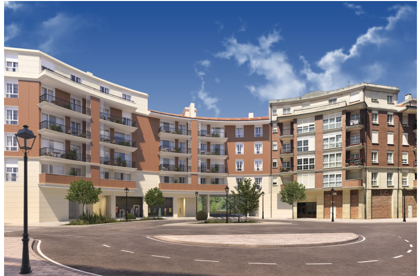
Vista general fachadas a calle Lasao (Alonsotegi)
