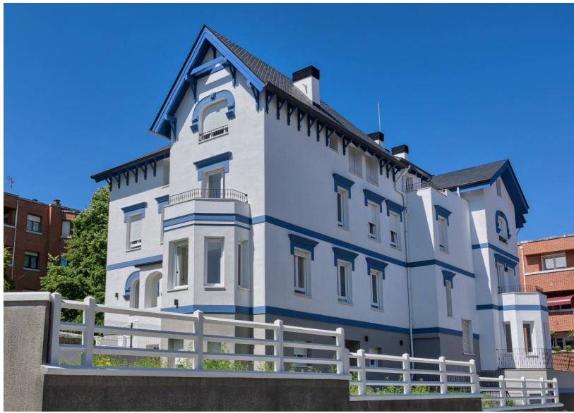
SanMartin25 – Getxo (Bizkaia) - Rehabilitación y nueva planta.
