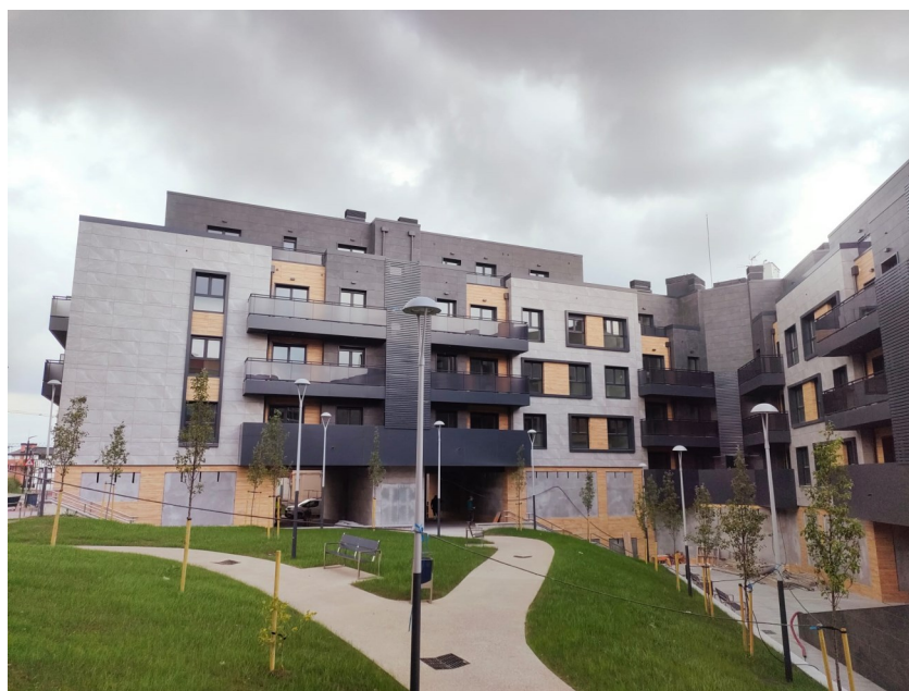
Goyetalde– Urduliz (Bizkaia) - Obra nueva edificación.
