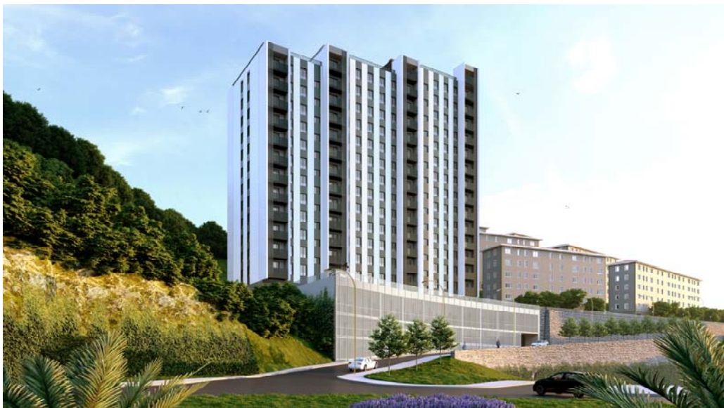
Vista general edificio Ribera Barakaldo
